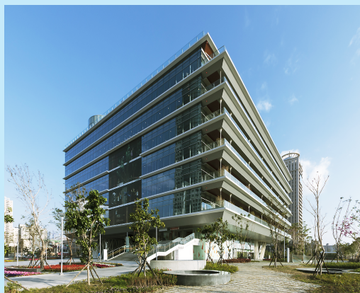
圖二．高雄市立圖書館總館完全以玻璃帷幕覆蓋八層樓現代建築。基地北側80公尺寬新光路往西直通新光碼頭，往東則可前往三多商圈，基地南側臨20公尺寬林森路，西行貫穿高雄展覽館之中央內街，可直達水岸
